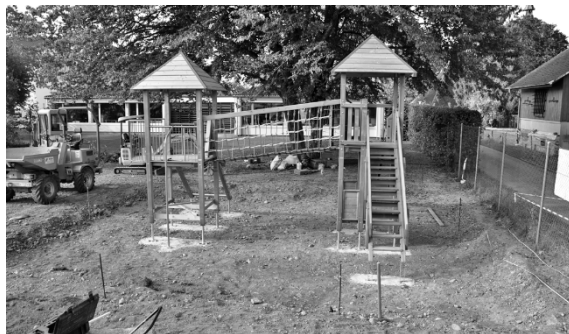
Im Herbst wurde der Spielplatz beim Doppelkindergarten saniert.
