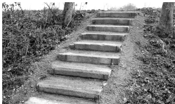
Durch den Werkhof erstellte Verbindungstreppe beim Kieswerkareal.
