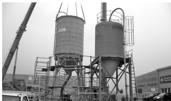
Salz- und Splittsilo im Industriegebiet (v. l.).
